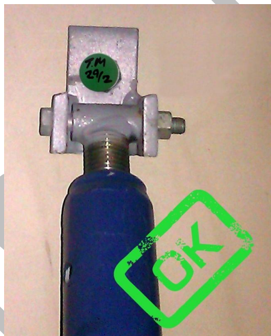
Bild 2. Stag med markör, OK att demontera
