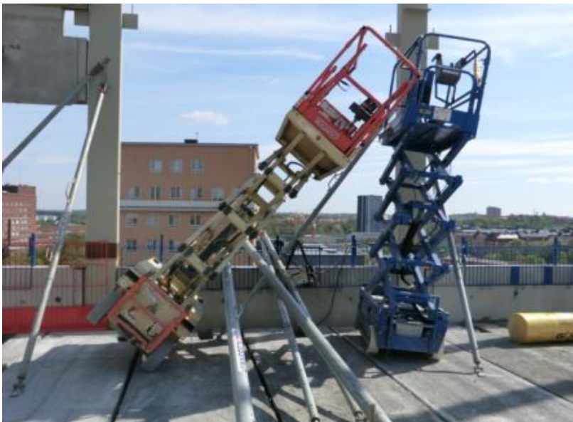
Figur 1 – Olycka på arbetsplats, skylift kör in i stag och välter
