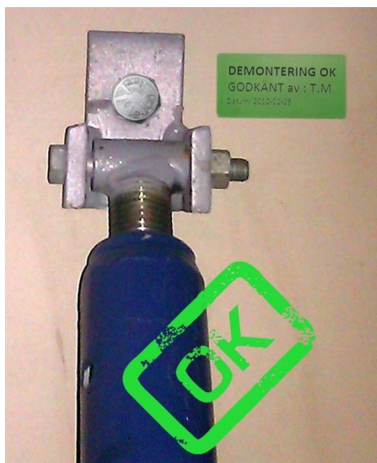
Bild 1. Stag med etikett, OK att demontera
